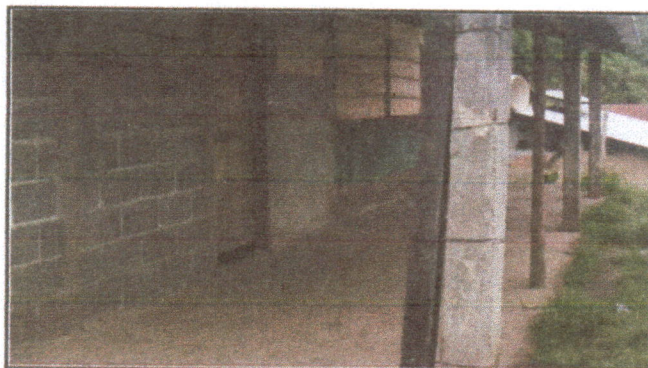
Foto 4: Sustrucion de piso de concreto en en todo el área a intervenir de 8*9m(72m²)
