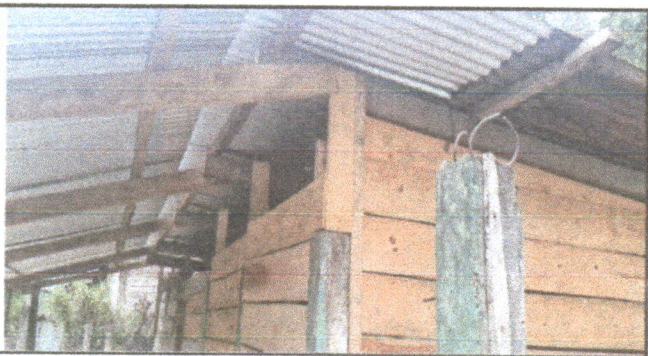
Foto 5: Sustrucion de pared de madera a pared de blocks y sustitucion de columnas.
