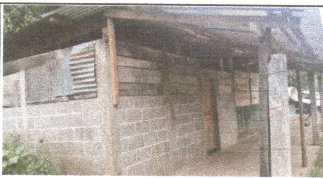
Foto 3: Sustrucion de puerta de madera a metal de 1.0*2.30m y ventanas de madera a metal de 1.25*1.70m
