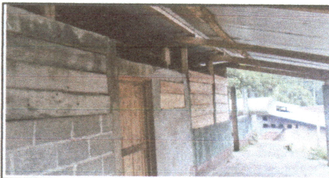
Foto 6: Intalacion de sistema eléctrico en área de mejoramiento.
