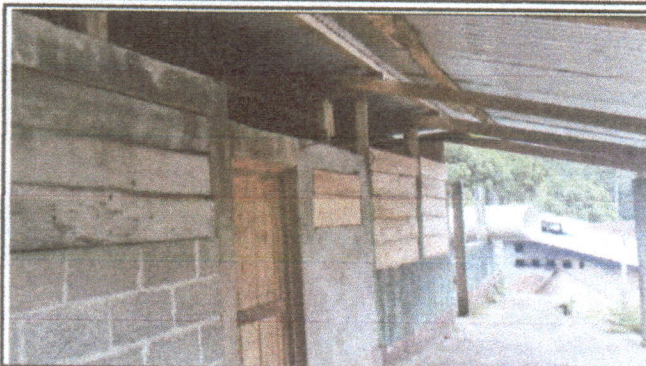
Foto 2: Sustrucion de portante de techo a costanera y viga de metal
