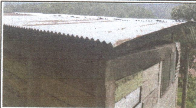
Foto 1: Sustrucion de techo de lamina a lamina troqueladas calibre 26 para mejoramiento de aula. En un area de techo de 9*10m(90²)
